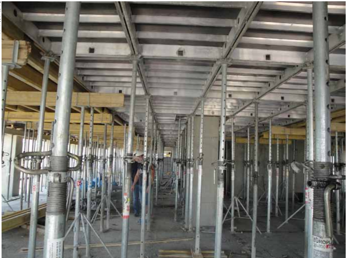
Początkowy etap montażu elementów szalunku ALUstrop. Widoczne zgromadzone elementy
