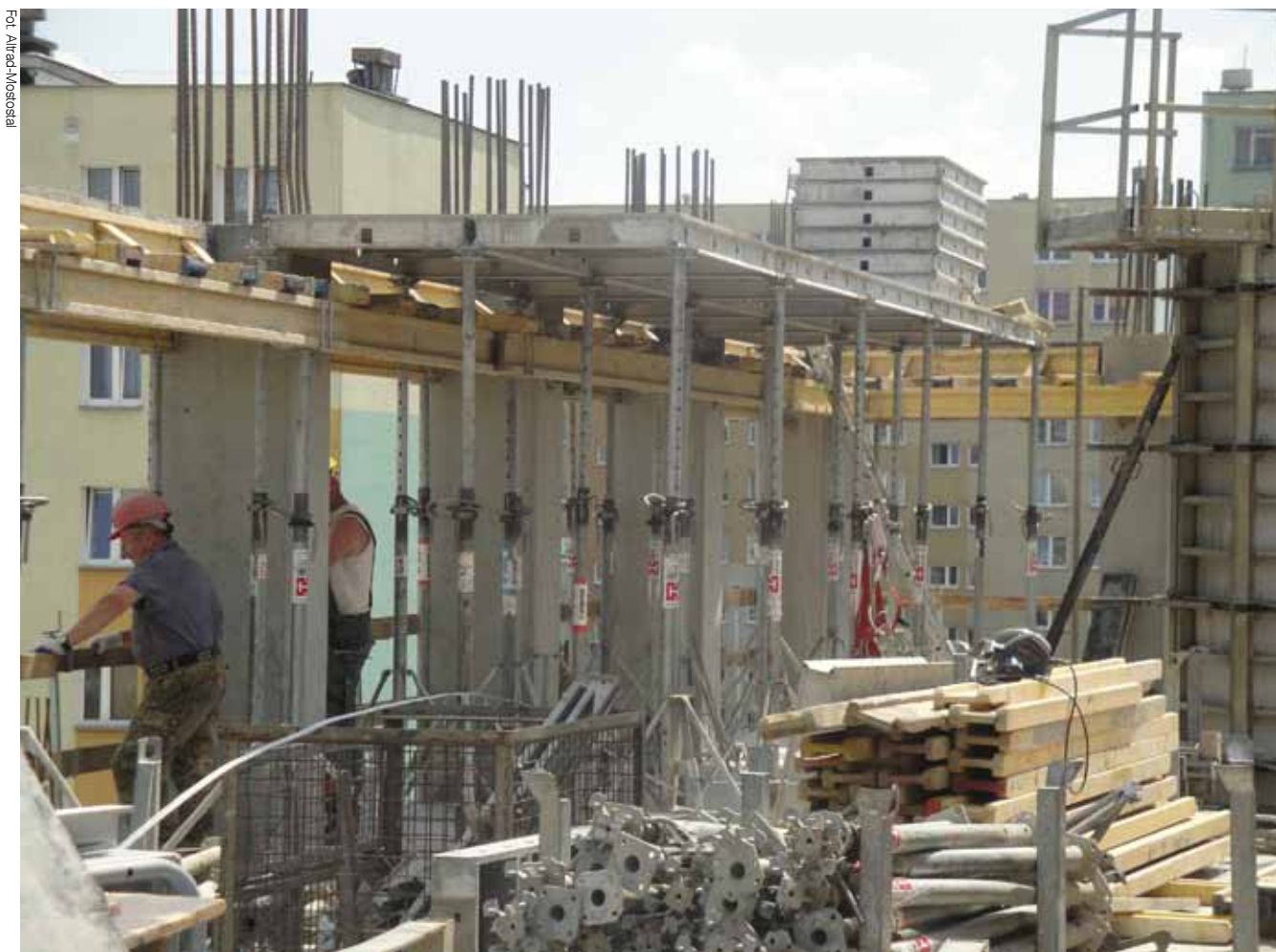
Gotowy, zmontowany szalunek stropowy ALUstrop
