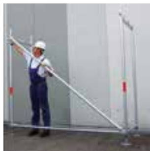
Zapiąć stężenie ukośne
