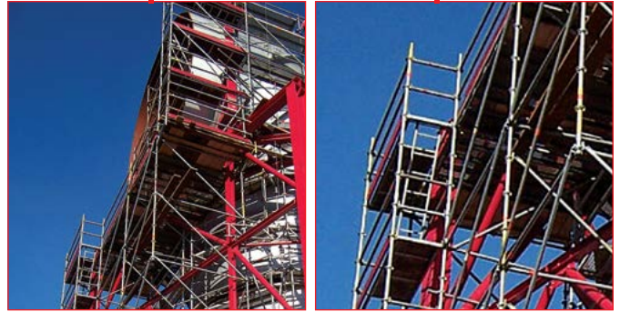
Elektrownia w Ostrołęce
