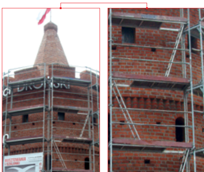
Renowacja fasady Baszty - Szczecin
