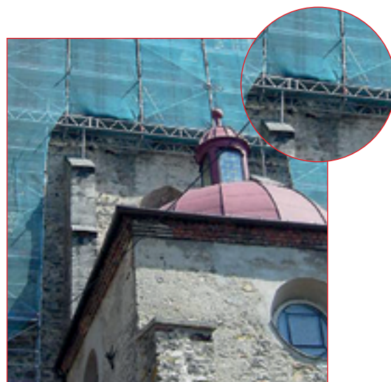
Renowacja fasady kościoła - Szydłowiec
