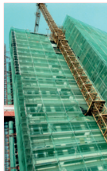
Budowa Apollo Rida - Warszawa
