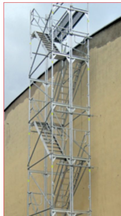
■ Przykład zmontowanej klatki dwuzabiegowej
