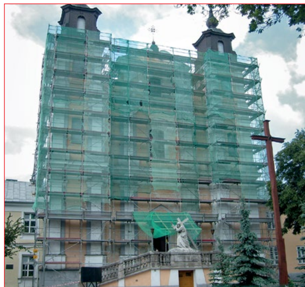
Przemienienie Pańskie Church - Łuków
