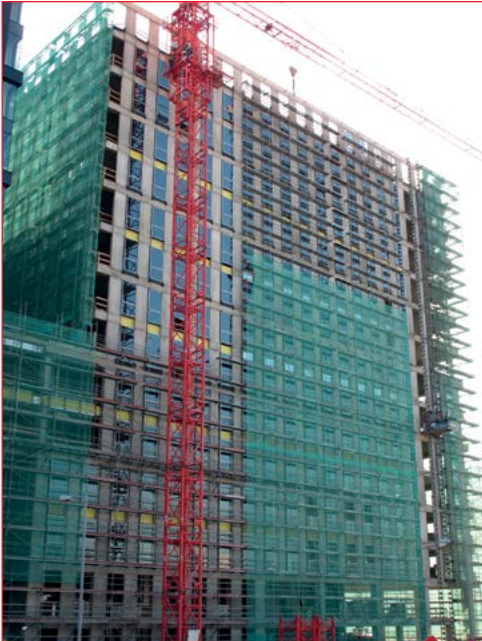
Строительство Кватро Бизнес Парк – Краков
