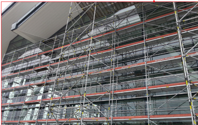
Работы на фасаде здания аэропорта
