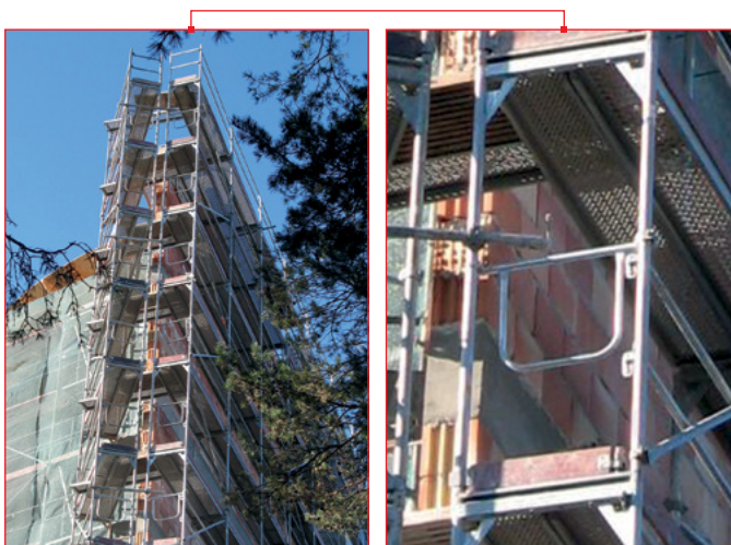
Przykłady zastosowania poręczy czolowej
