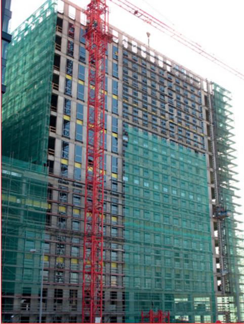
Строительство Кватро Бизнес Парк – Краков
