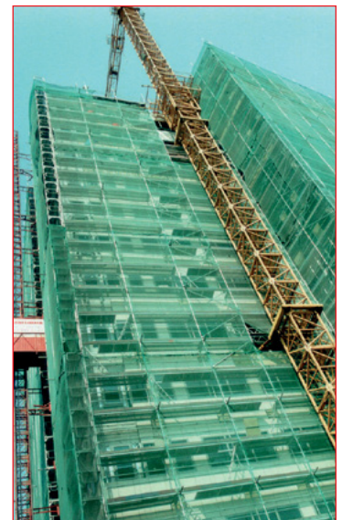
Строительство Аполло Рида - Варшава
